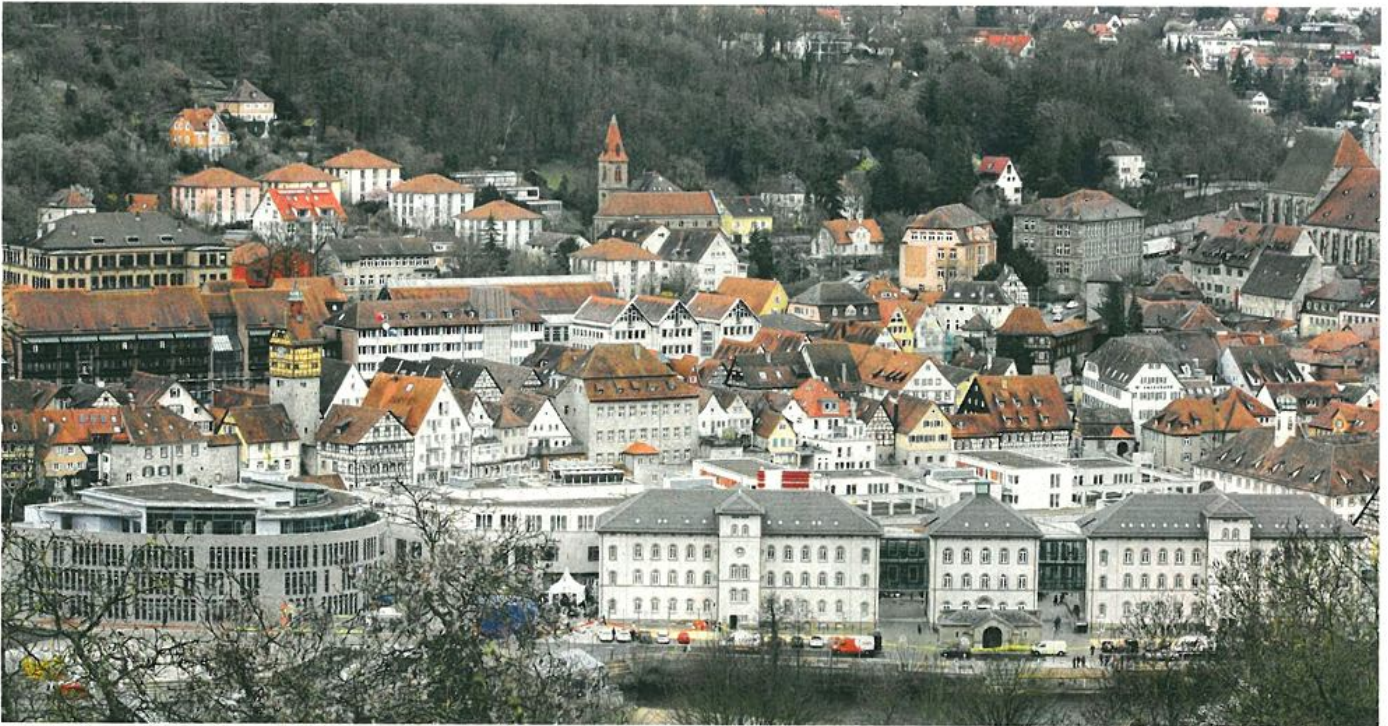
Eine neue Stadt (vorne), mitten in der alten: Handel, Dienstleistung, Bildung, Wohnen, Gastronomie, Parken und Flanieren gehen im Kocherquartier Hand in Hand.
