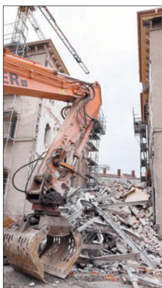
Die Verbindungsstücke des denkmalgeschützten ehemaligen Knastgebäudes werden im Juni 2010 abgerissen.
