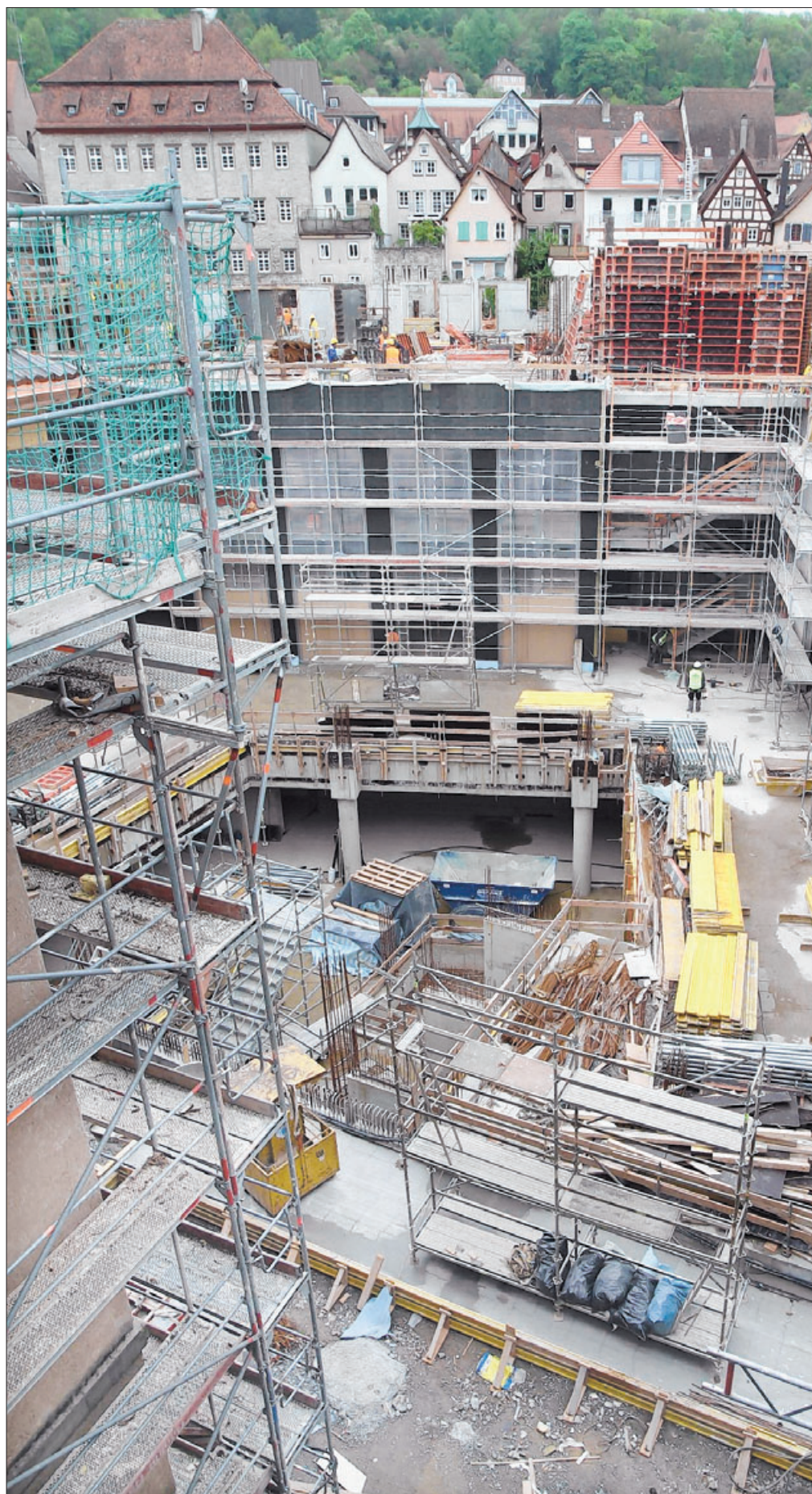
Vor gut einem Jahr gab es einen Einblick ins Bauwerk – heute befindet sich dort eine beeindruckende Glaskonstruktion mit Aufzügen und Treppen.
