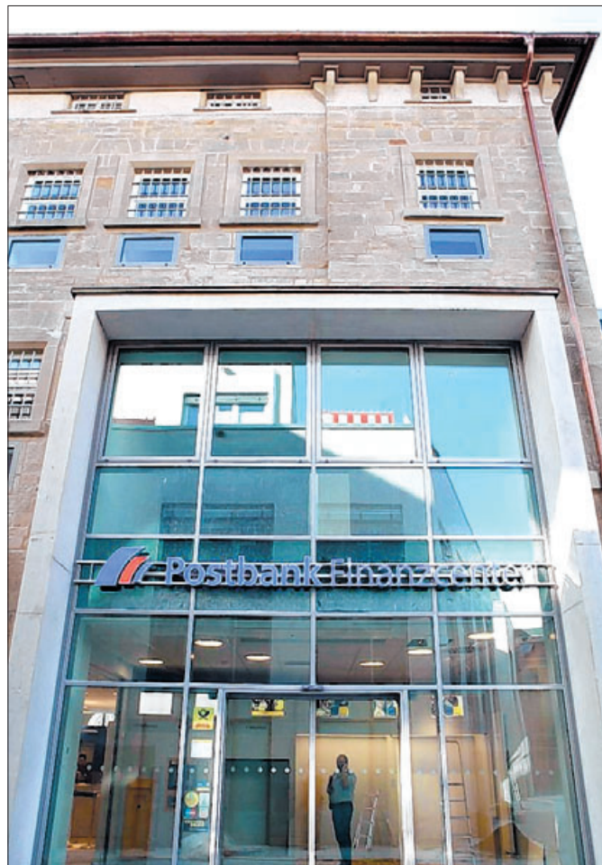
Neu trifft auf alt: Eine moderne Glasfront an der historischen Gefängnisfassade.
